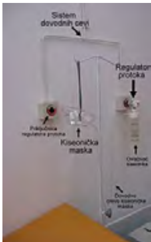
Slika 2-11. Dopremanje kiseonika sistemom dovodnih cevi
